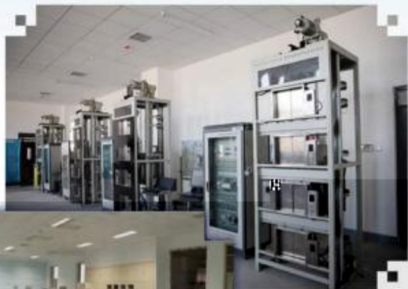
智能电梯安装调试 维护训练场所
